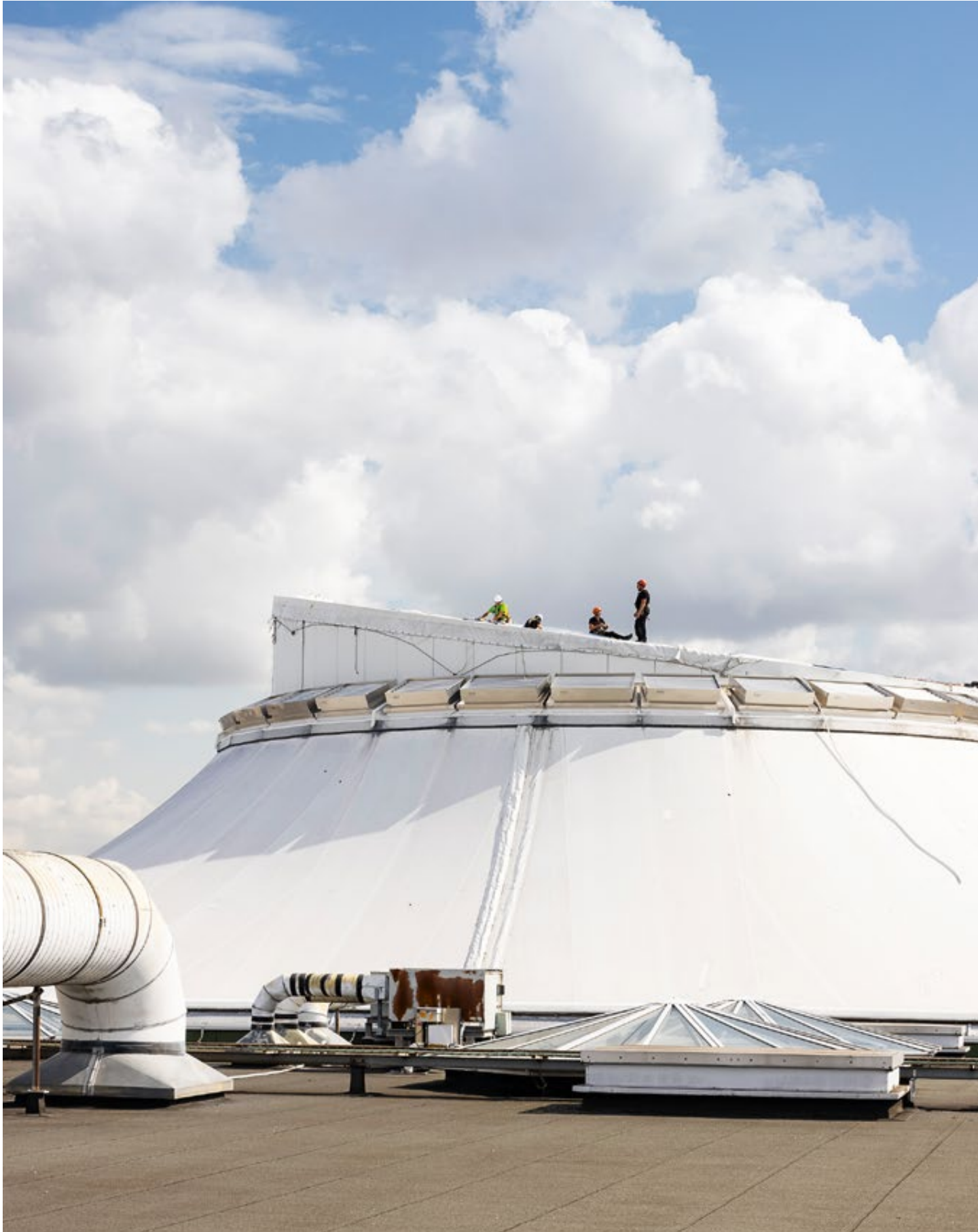
→ Une des coupoles de la Cité des sciences et de l'industrie vue depuis le toit du bâtiment lors des travaux de restauration. © universcience
